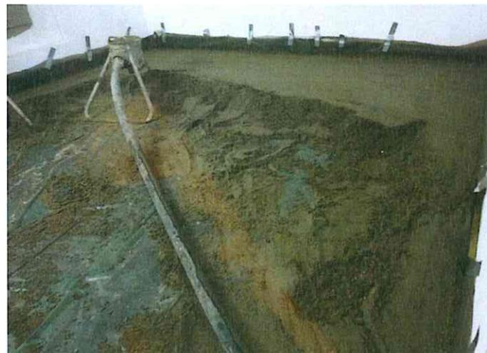
**Abbildung A 2.2:** Montagesituation mit Zementestrich
