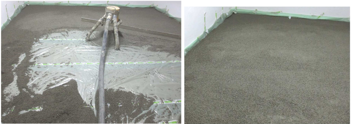
Abbildung A 2.1: Montagesituation – Einbau der Ausgleichsschüttung
