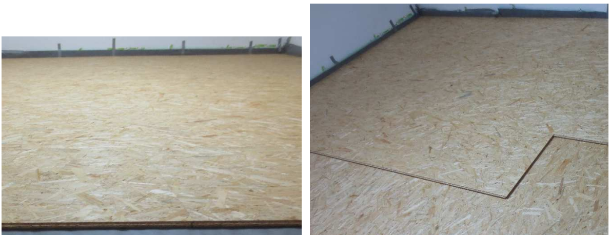
Abbildung A 2.3: Montagesituation Trockenestrich
