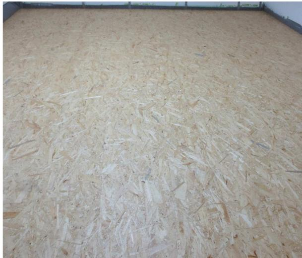
**Abbildung A 2.5:** Trockenestrich (Prüfsituation)
