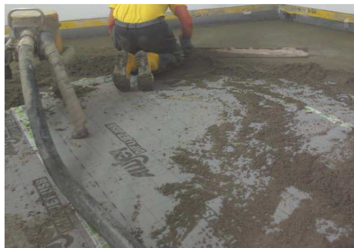
Abbildung A 2.2: Montagesituation mit Zementestrich
