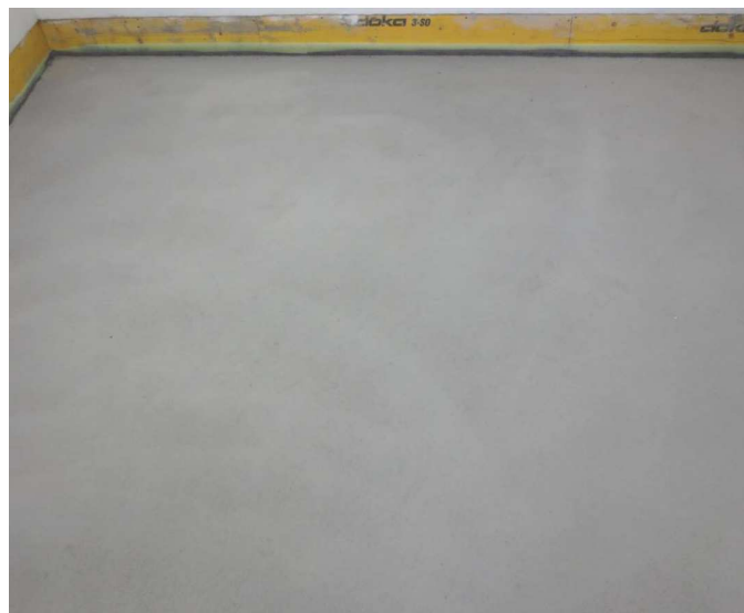
Abbildung A 2.3: Zementestrich (Prüfsituation)
