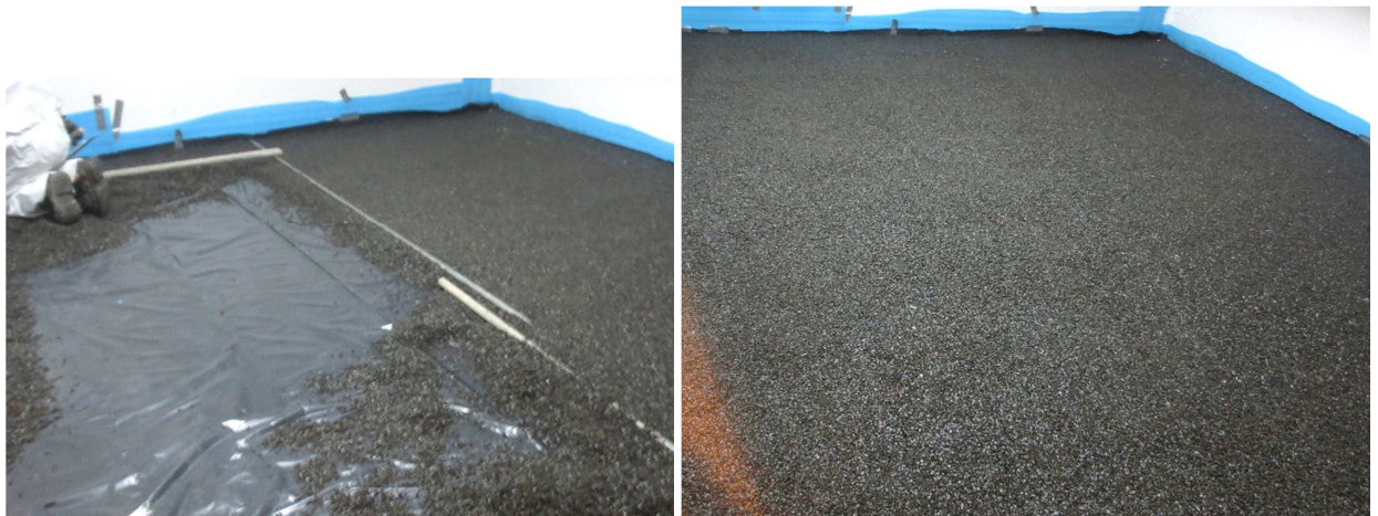
Abbildung A 2.1: Montagesituation – Einbau der Ausgleichs- und Schalldämmschüttung
