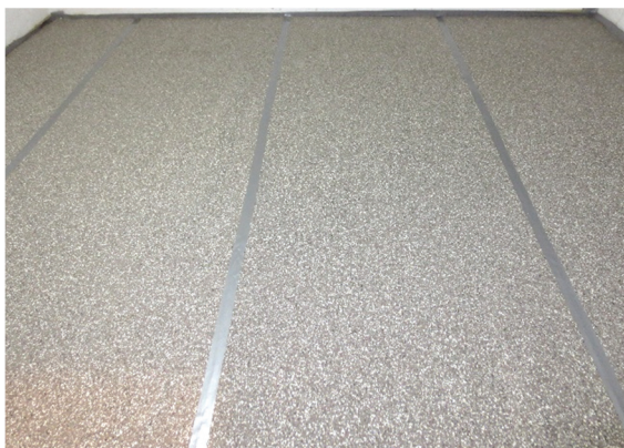
Abbildung A 2.2: Montagesituation – Einbau der Ausgleichs- und Schalldämmschüttung
