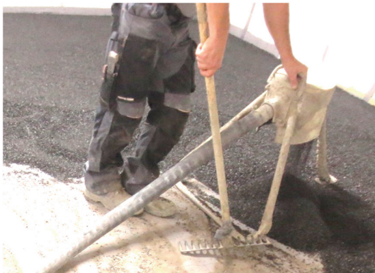
Abbildung A 2.2: Montagesituation – Einbau der Ausgleichs- und Schalldämmschüttung
