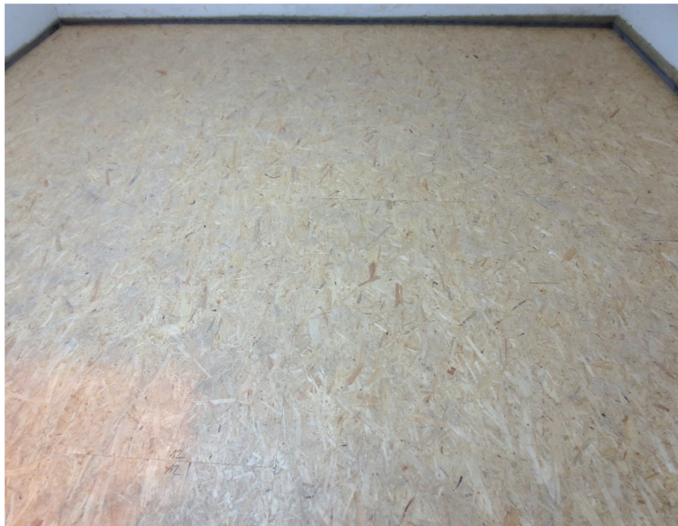
Abbildung A 2.5: Trockenestrich (Prüfsituation)
