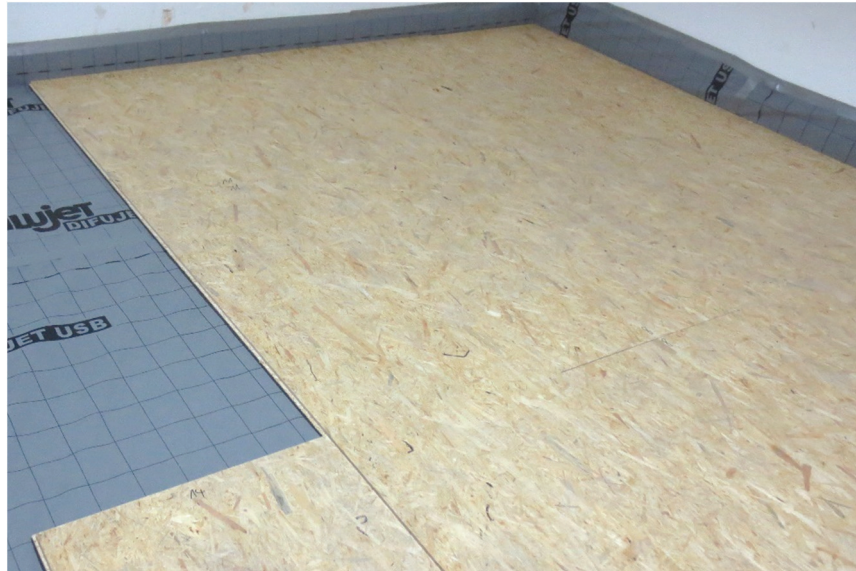
Abbildung A 2.4: Montagesituation Trockenestrich
