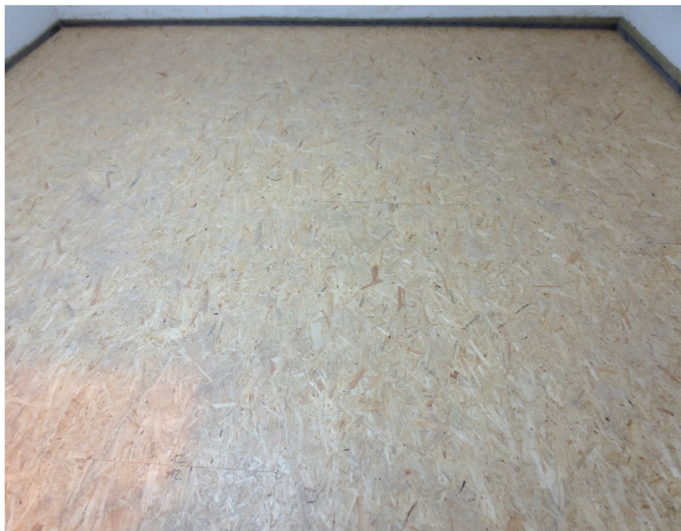
Abbildung A 2.5: Trockenestrich (Prüfsituation)
