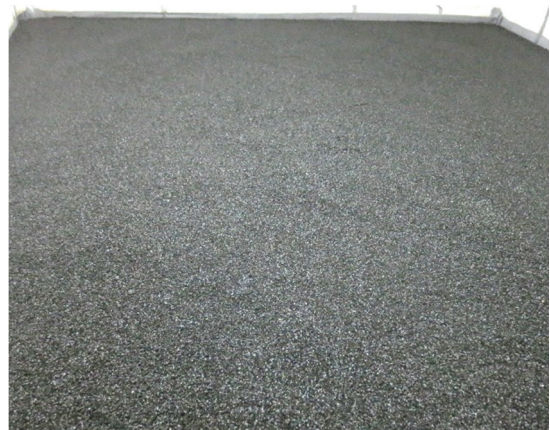
Abbildung A 2.2: Montagesituation – Einbau der Ausgleichs- und Schalldämmschüttung
