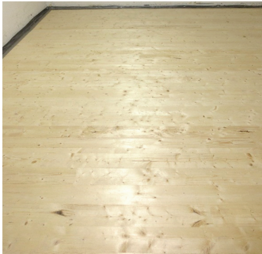
a) Abbildung A 2.1: Massivholz-Rohdecke a) oberseitig, vor dem Einbau des Fußboden- aufbaus, b) unterseitig
