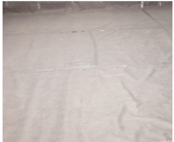
Abbildung A 2.2: Montagesituation a) Verlegung der Trittschalldämmmatten auf der erhärteten Ausgleichs- und Schalldämmschüttung, Stöße mit Klebeband, b) nach Auflegen der RenoScreed SarkingMembrane Bahn
