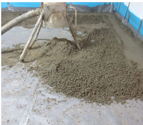
Abbildung A 2.3: Montagesituation Zementestrich
