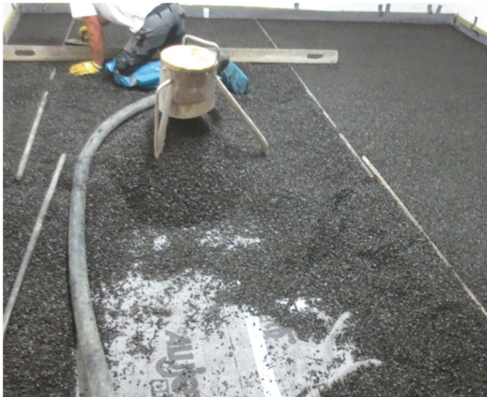
Abbildung A 2.2: Montagesituation – Einbau der Ausgleichs- und Schalldämmschüttung
