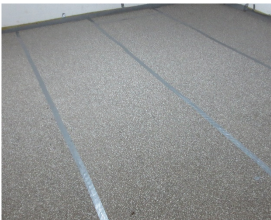
a) b) Abbildung A 2.3: Montagesituation a) Verlegung der Trittschalldämmmatten auf der erhärteten Ausgleichs- und Schalldämmschüttung, Stöße mit Klebeband, b) nach Auflegen der Alujet Difujet Bahn
